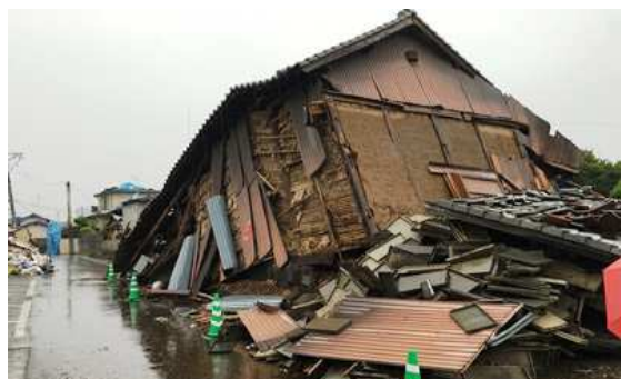
熊本地震で倒壊した家屋 なすまどか熊本市議（日本共産党）提供
