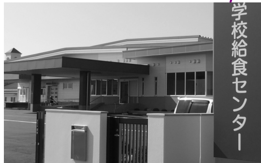
完成間近の学校給食センター
